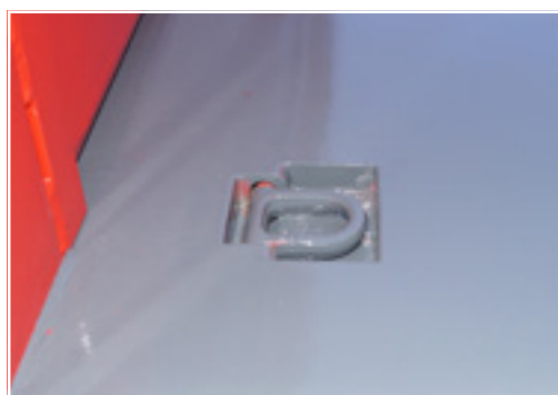
Zurrmulde im Boden versenkt, 2500 kg DIN EN 12640
